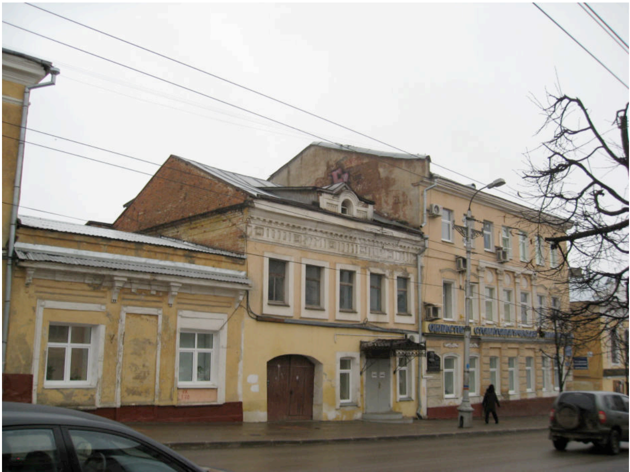
Фото 3. Вид зданий до реконструкции 2012 – 2013 гг.
