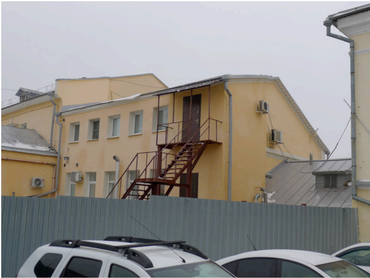
Фото 21. Вид с юга.
