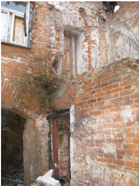
Фото 5. Вид со двора. Проездная арка (слева) и частично сохранившаяся лестничная клетка. Снимок до реконструкции 2012 – 2013 гг.
