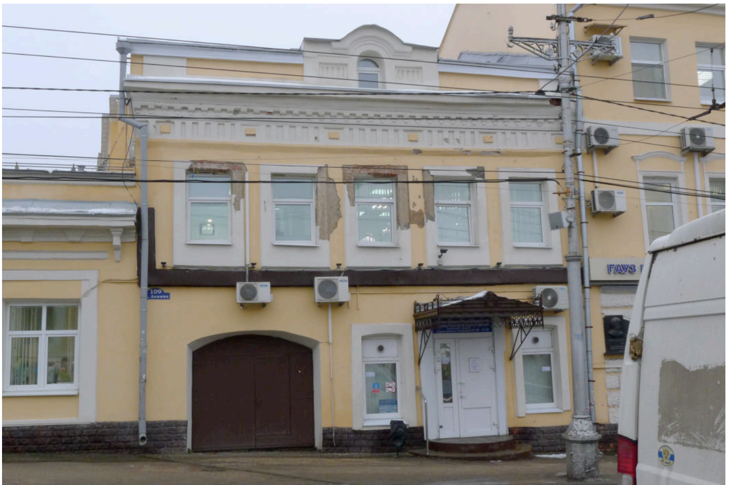
Фото 12. Уличный фасад 2-этажного здания.
