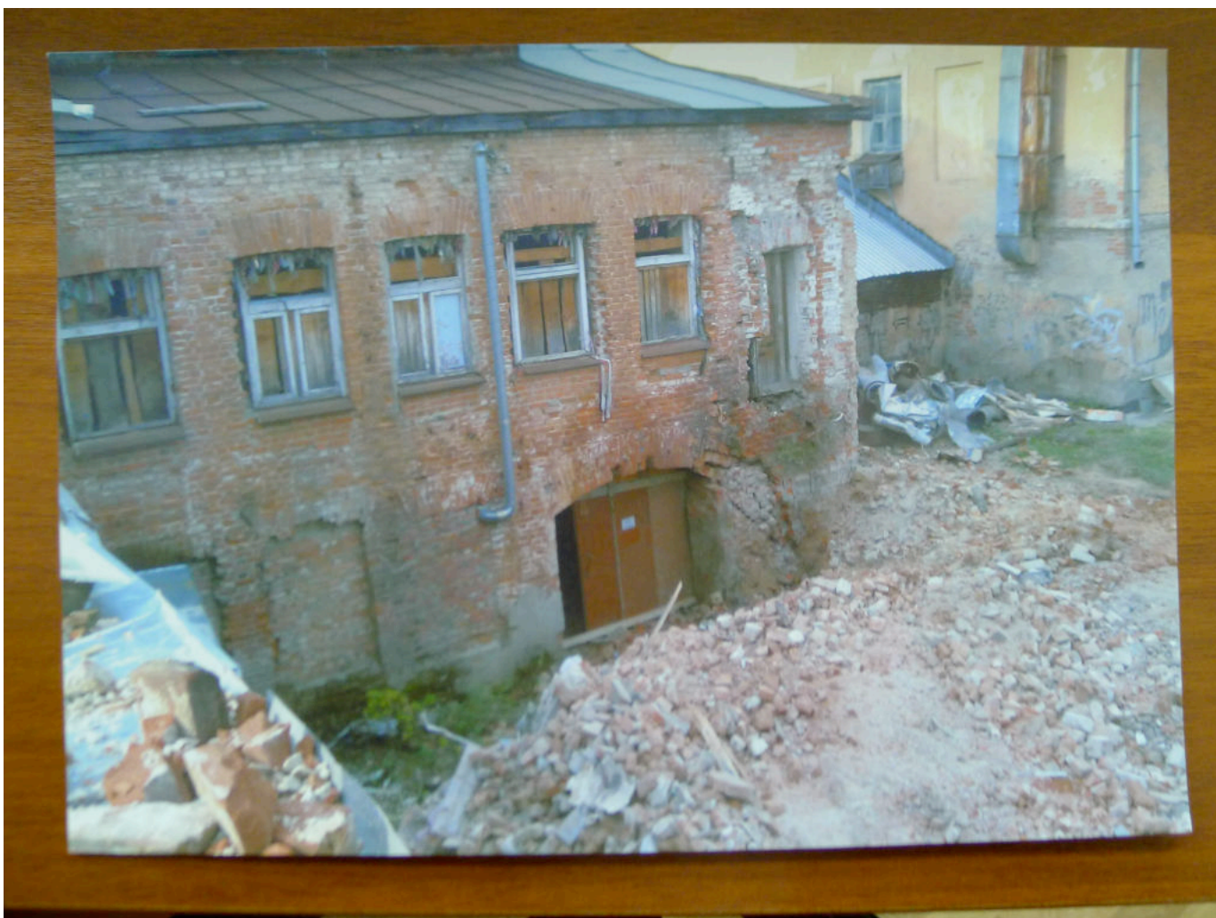
Фото 6. Вид со двора. Снимок до реконструкции 2012 – 2013 гг.
