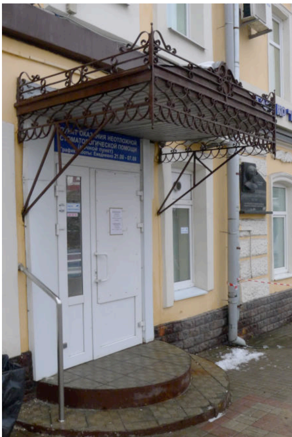
Фото 13. Козырек над главным входом в здание.
